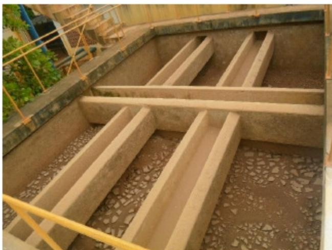
**Foto 5.20 – Filtros aguardando troca de material filtrante**
